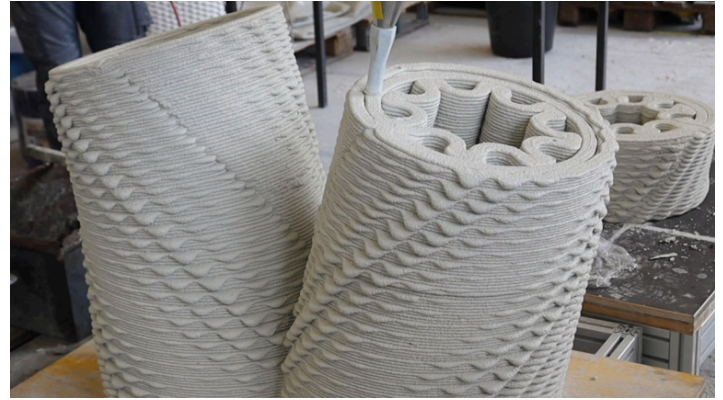
Il. 13. Proces druku kolejnych segmentów Białej wieży z uwzględnieniem miejsca na zbrojenie; fot. A. Anton, C. Lin, M. Yang (M. Hansmeyer, Tor Alva (The White Tower) , Mulgens, 2025, Michael Hansmeyer, michael-hansmeyer.com/white-tower [data dostępu: 12.3.2026])
